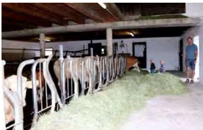
Das Altgebäude im hinteren Bildteil wurde umgebaut, der Zubau im Vordergrund beherbergt Liegeboxen und Kälberschlupf.
